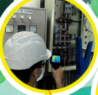
電力盤熱點量測
